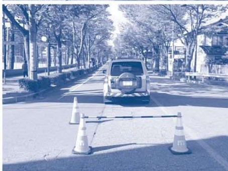
舗装補修を予定している道路（神通町蛸川線）（上） 現場確認の様子（下）
