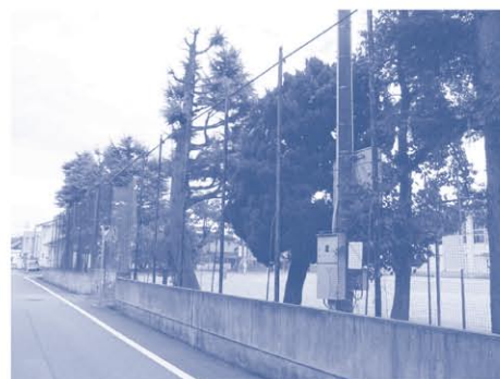
全面更新される柳町小学校の防球ネット
