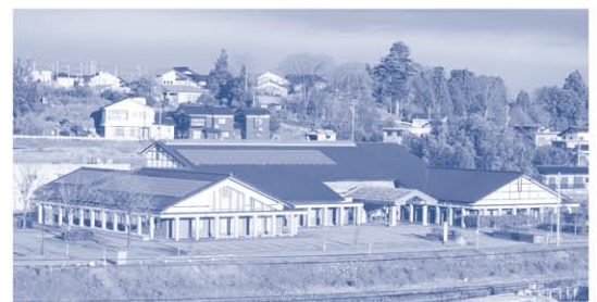
八尾行政サービスセンターの機能の移転が予定されている 八尾健康福祉総合センター
