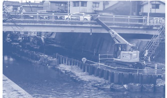
八田橋架替（旧橋脚撤去）工事の様子（永楽町外地区）
