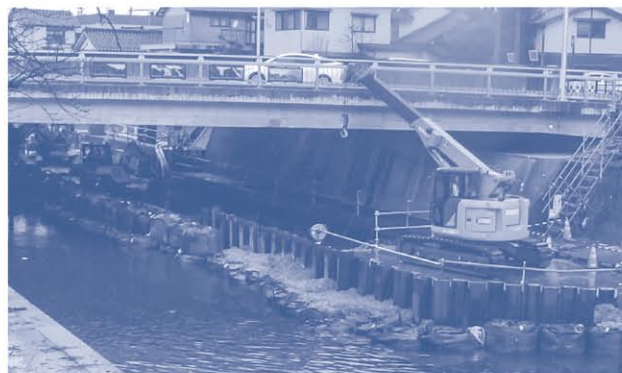
八田橋架替（旧橋脚撤去）工事の様子（永楽町外地区）
