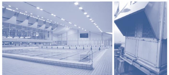
空調設備の更新が予定される富山市民プール プール（左）、空調設備（右）
