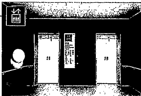
中央エレベーター
