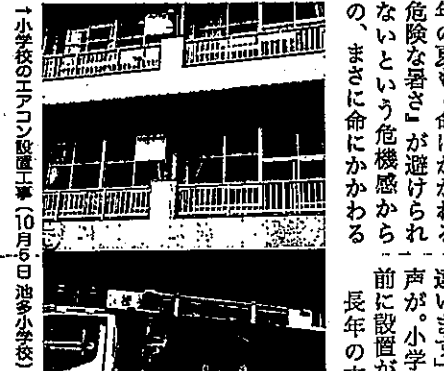
→小学校のエアコン設置工事(10月6日池多小学校)
