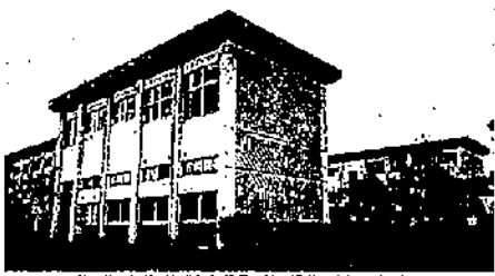
義務教育学校(仮称) 水橋地区の旧浦田小学校校舎
