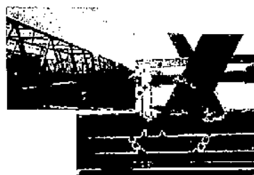
鋼トラス斜材の破断(2007年, 国道23号木曾川大橋)
