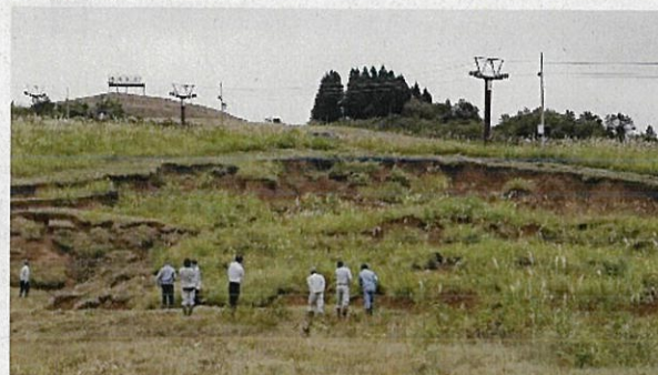
【地滑り発生箇所】
