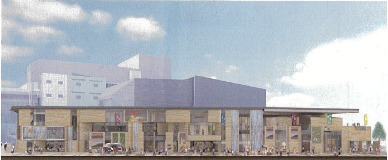
外観全景（北側）
