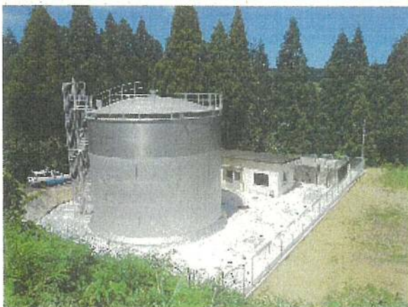
写真 山田低区配水場配水池
