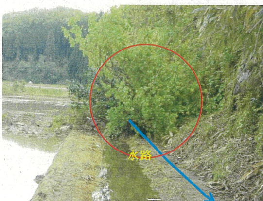
○婦中町上瀬(水路)
