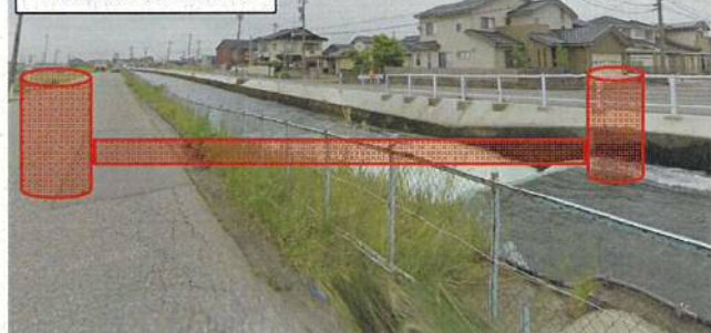
防護管布設工事 (常西用水横断部)
