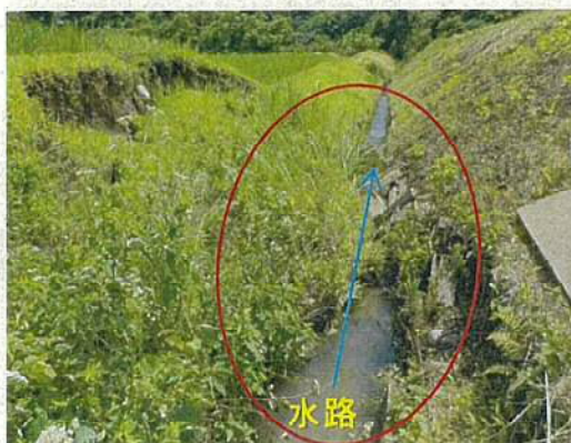
○八尾町掛畑地区(水路)
