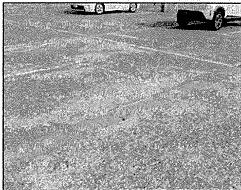
駐車場の舗装
