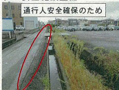
転落防護柵設置
