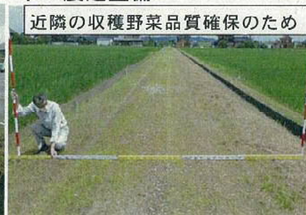
砂利道のアスファルト舗装
