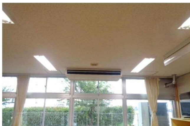
図 II-11 小・中学校空調整備事業 (杉原小学校)
