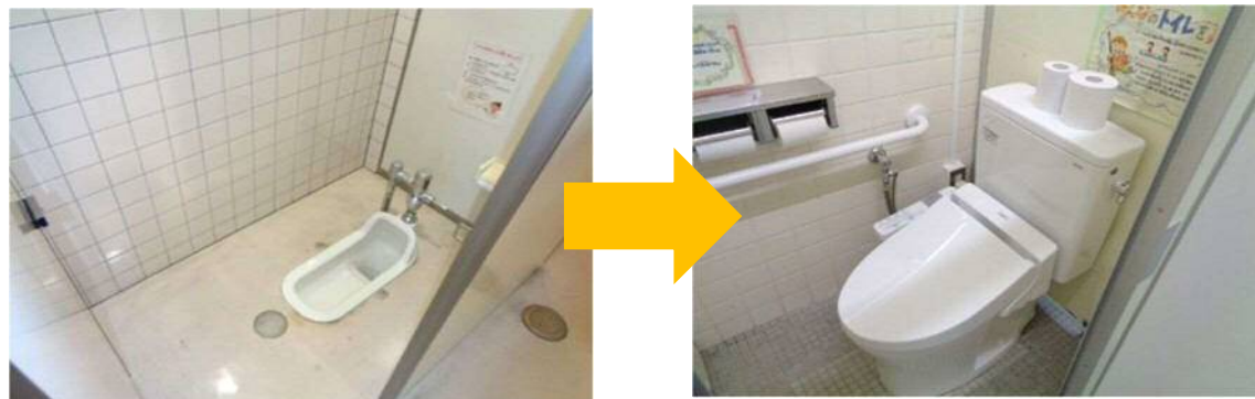
図 II-12 小・中学校トイレ環境改善事業（広田小学校）
