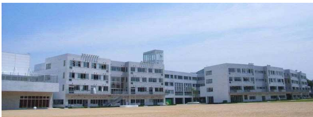
図 II-32 芝園小・中学校校舎（上）と中央小学校校舎（下）
