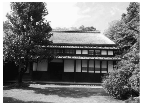
保存修理工事が完了した主屋
