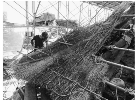
主屋茅葺屋根葺き替え風景
