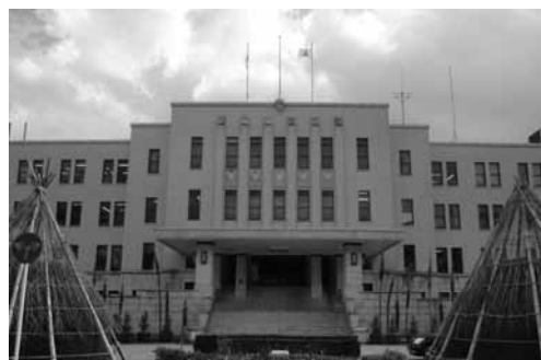
富山県庁舎本館
