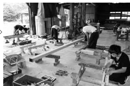
竹島家住宅長屋門修繕の様子
