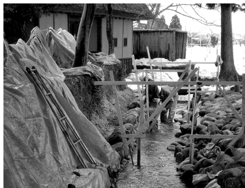
修理工事風景
