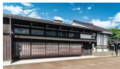
旧馬場家住宅外観（表側）
