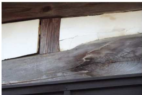
石置屋根上壁剥離
