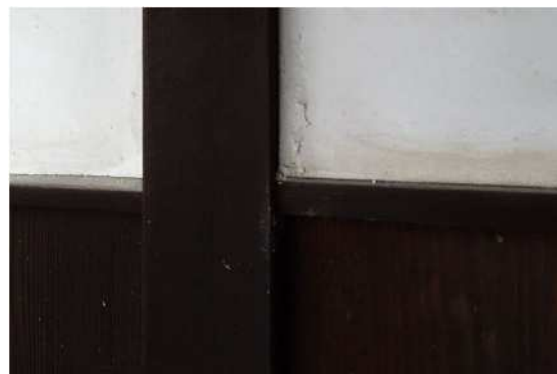
室内壁亀裂・剥落
