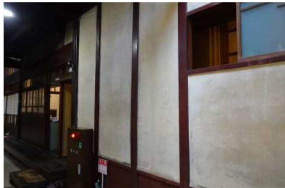
中央の半柱が二階隅柱の重みで張り出す
