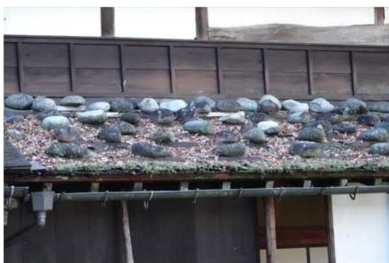
石置屋根の石が上段から下段に落下
