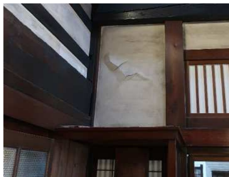
中央の半柱が二階隅柱の重みで張り出す
