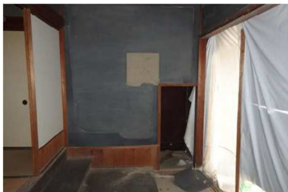
室内壁亀裂・剥落
