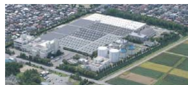
浜黒崎浄化センター
