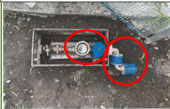
同時閉栓の場合面間寸法測定
