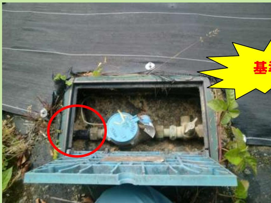
メーター2次側から**直接ビニル管で施工**
