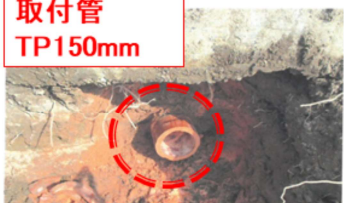
取付管の管種がわかる写真。 欄外に管種と口径を表記
