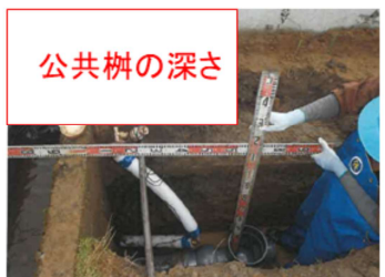
取付管の管種がわかる写真。 欄外に管種と口径を表記
