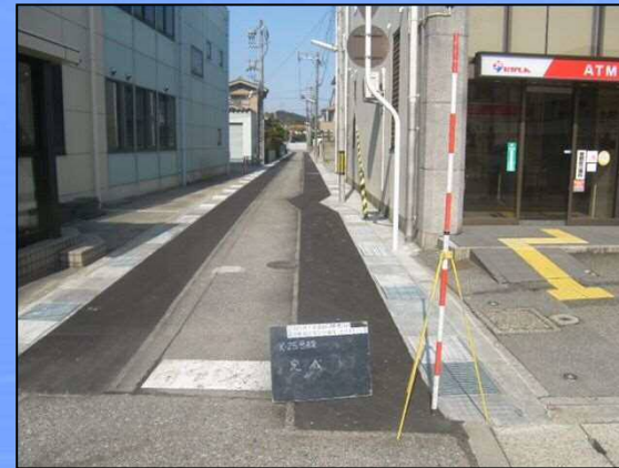
施工写真②
