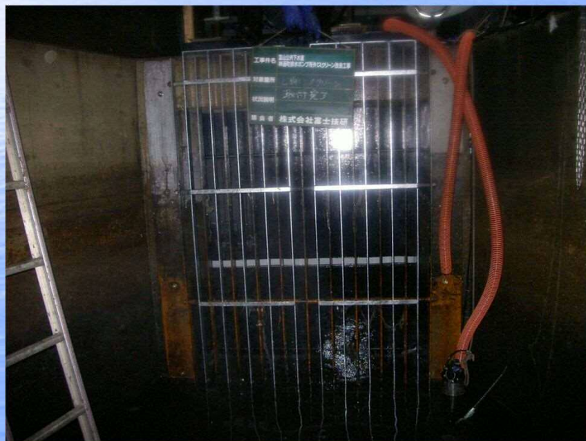
現場写真 (七軒町ポンプ場スクリーン設置状況)
