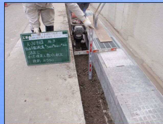
施工写真①
