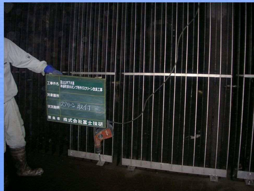
現場写真 (神通町ポンプ場スクリーン設置状況)
