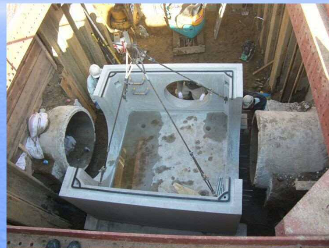
現場写真① (分水人孔)
