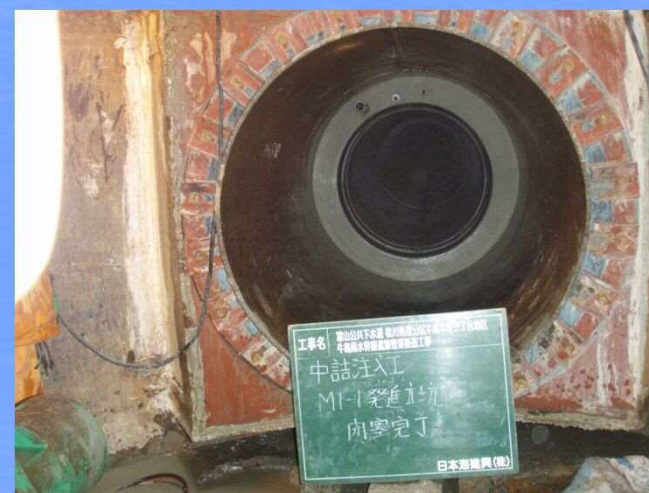
現場写真② (遮集管)
