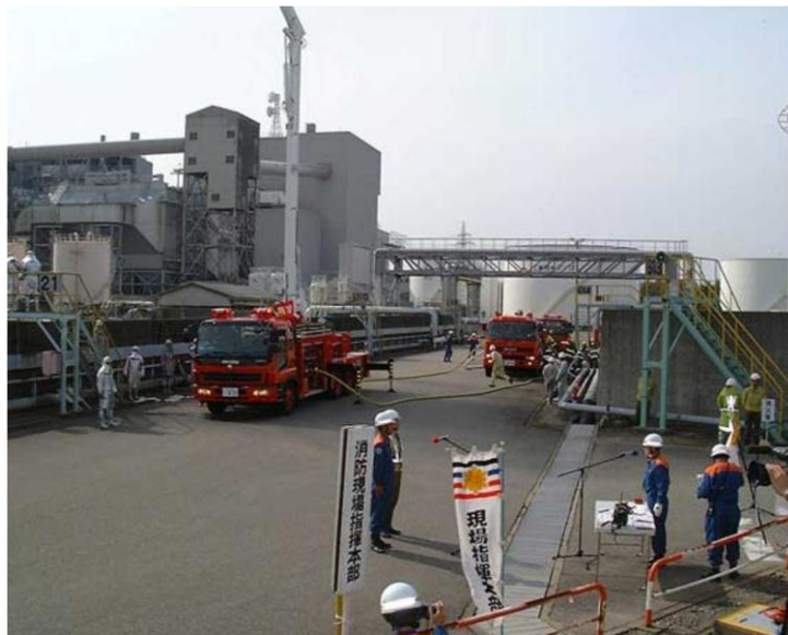
石油コンビナートの災害における訓練風景
