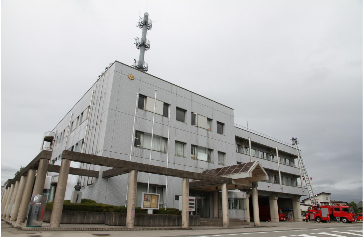
富山市消防局・富山消防署 合同庁舎
