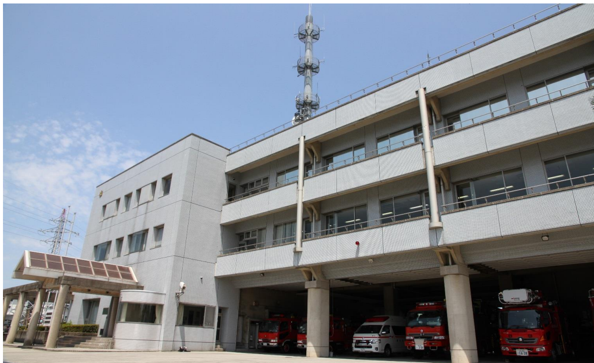
富山市消防局・富山消防署 合同庁舎
