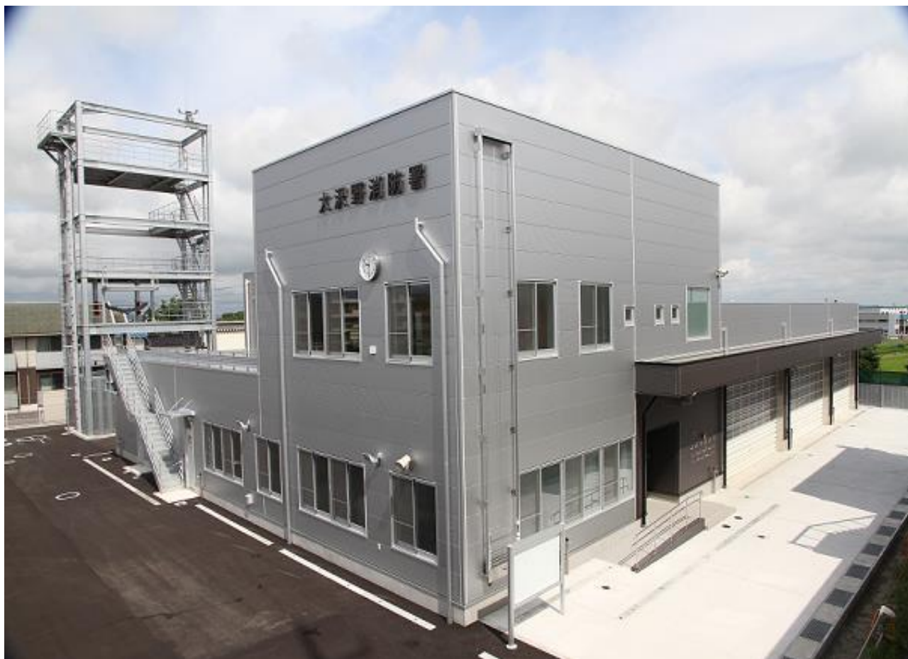
大沢野消防署 新庁舎（令和2年7月運用開始）
