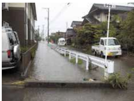
下富居での浸水
