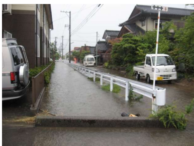
下富居での浸水
