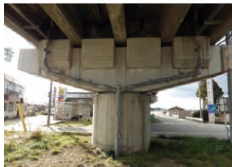
橋脚柱の耐震補強
