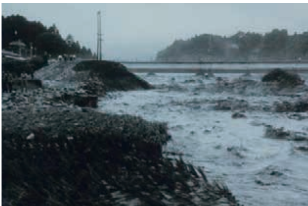
昭和44年常願寺川の破堤の状況
