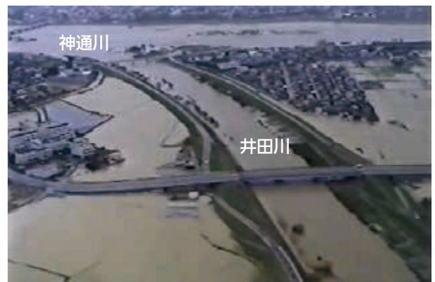
平成16年台風23号の浸水被害の状況
