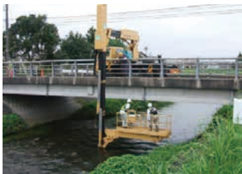
橋りょう点検車による点検作業
