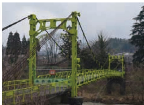
老朽化による通行止め
