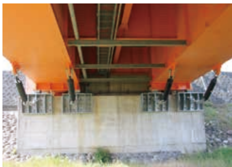
桁支点部での落橋防止装置の設置
