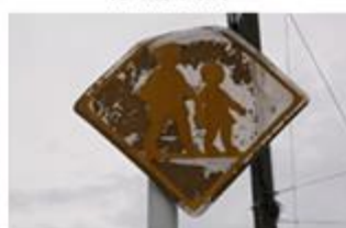
警戒標識の塗装の剥がれ
