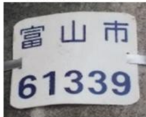
LED道路灯管理プレート
