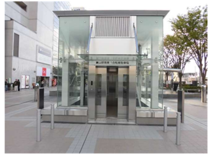
【富山駅南第1自転車駐車場エレベーター】
