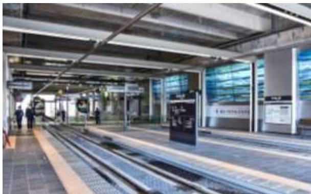
路面電車の南北接続
