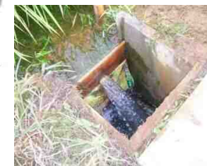
堰板設置状況
