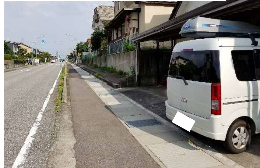
水路断面の拡幅（側溝改修）
