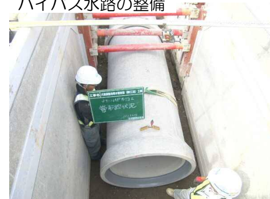
バイパス水路の整備
