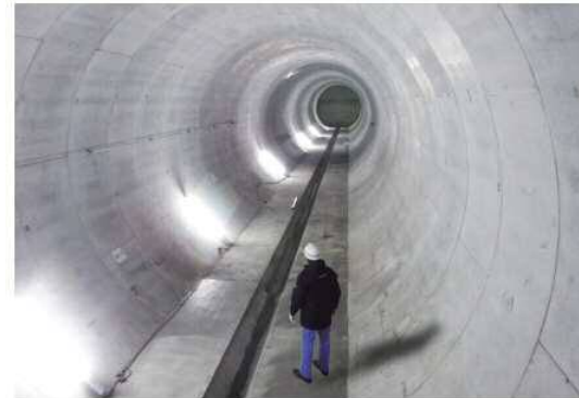
完成後の松川雨水貯留施設内
