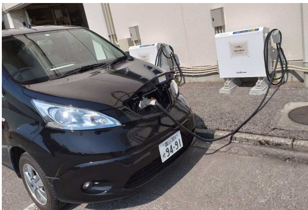
図表 53 婦中体育館に設置されている公用車用の充放電器
