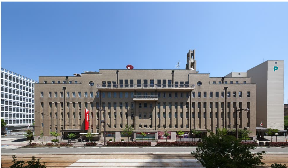
富山電気ビルディング本館（西より）
