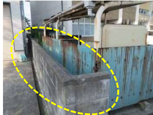
塀の高さ 113cm、長さ 44m、控壁の長さ 40cm、控壁の間隔 最長 7.7m
