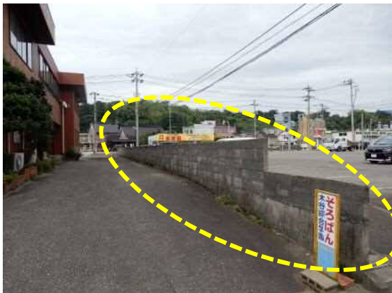
塀の高さ 153cm、長さ 44m、控壁なし
