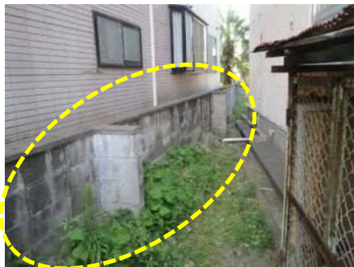
塀の高さ 113cm、長さ 44m、控壁の長さ 40cm、控壁の間隔 最長 7.7m
