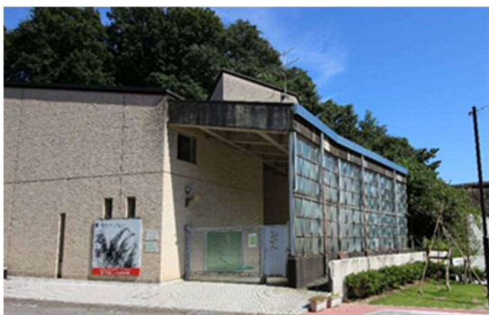
ガラス壁面遠景（高 3.8m × 幅 13.3m）
