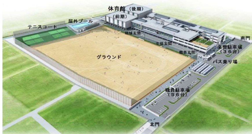
施設全景（北側俯瞰図）
