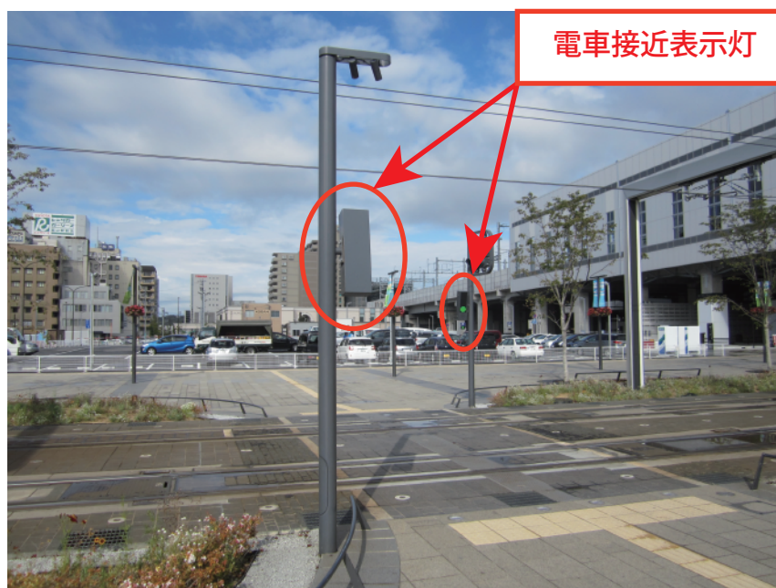
軌道横断部（南口駅前広場）
