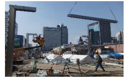
■ 工事の様子(第1期)
