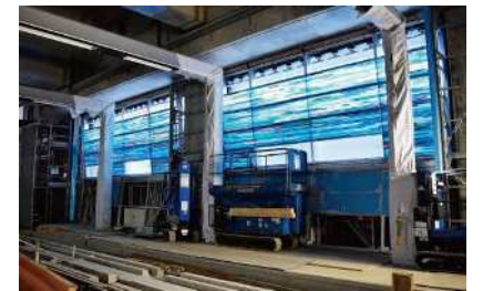
■ 工事の様子(第2期)
