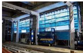
■ 工事の様子（第2期）
