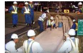
■ 軌道路盤工事
