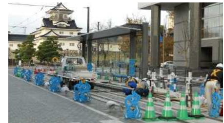
■ 停留場工事（国際会議場前停留場）
