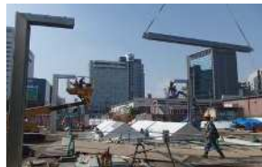
■ 工事の様子（第1期）
